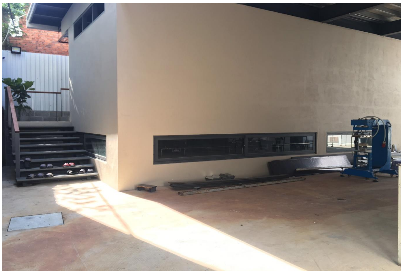
HỆ THỐNG XỬ LÝ NƯỚC THẢI XI MẠ, MỰC, SƠN
