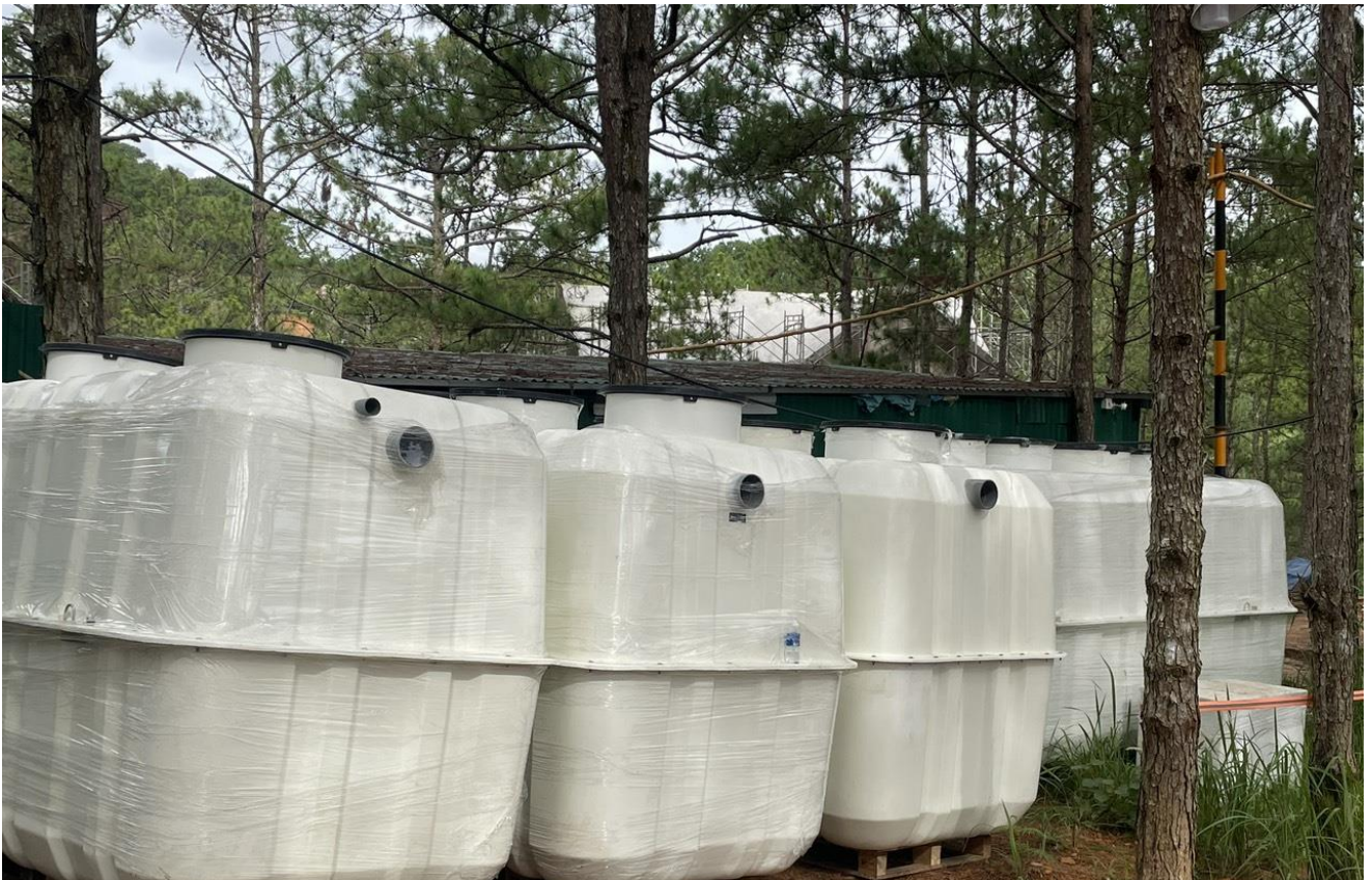
HỆ THỐNG XỬ LÝ NƯỚC THẢI RESORT, KHU DU LỊCH
